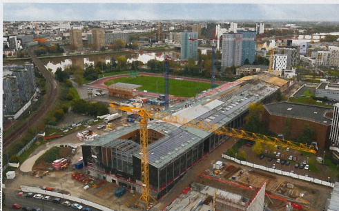
Le lycée en chantier. Bordé par un stade, le conservatoire régional et le Pôle interrégional d'enseignement supérieur de spectacle vivant (livré en 2015), il sera l'un des éléments phares du grand projet urbain de l'île de Nantes.
