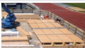
Stockage et assemblage solives-platelage sur chantier.
